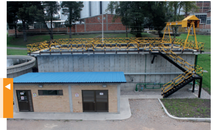
◀ Maltería Tropical Cartagena Sistema Aerobio LAC 1.2 t. DQO / día - 18 LPS
