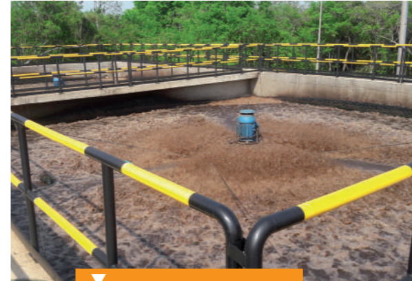
▼ Maltería Tibitó Sistema Aerobio LAC 1 t. DQO / día -12 LPS
