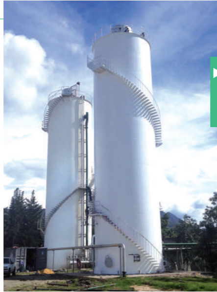
◀ Cervecería del Valle Reactor Anaerobio-AT 9.2 t. DQO/día - 34 LPS
